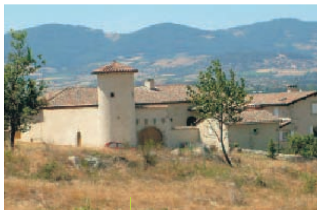
Ferme de la Roche à St Andéol le Château
