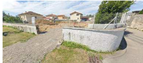
Après (Beauvallon, rue du Breuil)
